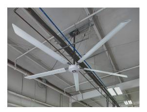
Hunter Fan ofrece ventiladores de alta velocidad y baja velocidad (HVLS) para uso industrial y comercial.
